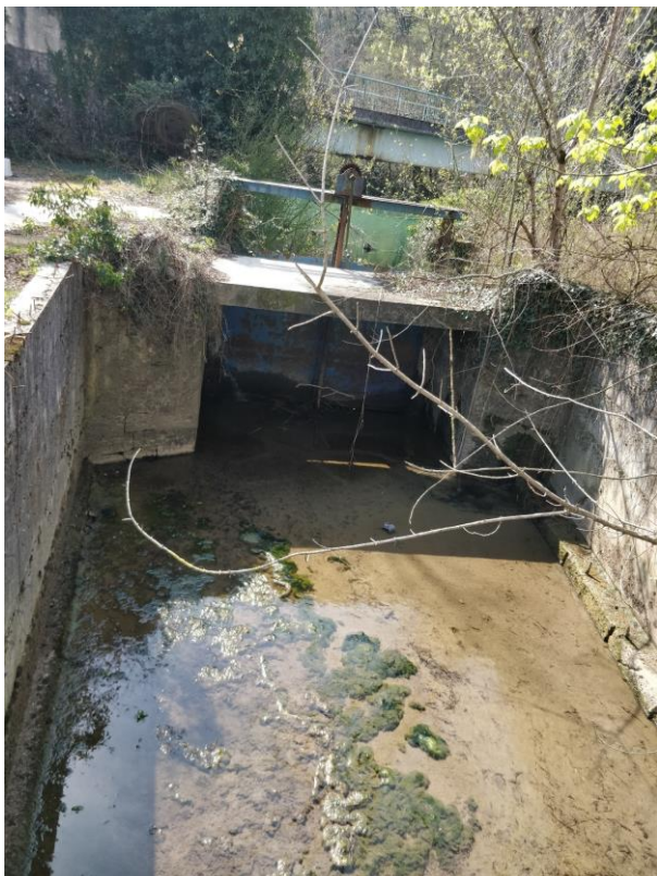
Slika 12: Betonsko korito umetnega kanala za posebno rabo vode na območju IOC Batuje, ki bo z izgradnjo protipoplavnih ukrepov ukinjen.
