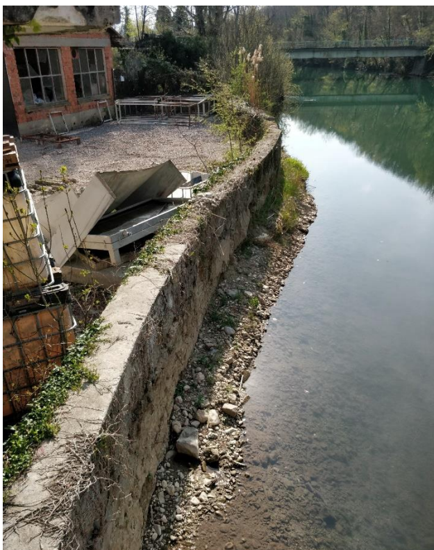
Slika 16: Obstoječi betonski protipoplavni zid gorvodno od jezua. Fotografirano na terenskem ogledu območja posega dne 07. 04. 2023.
